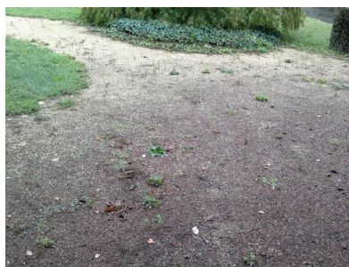
Cours constituées de graves hydrauliques
